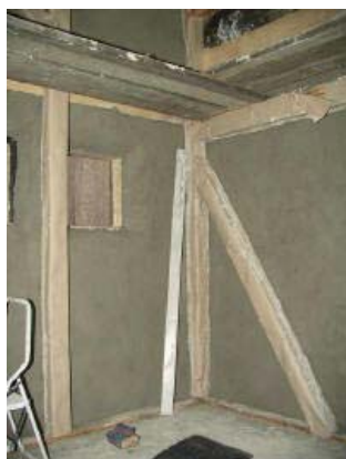
Rammeverket er her beskyttet mot søl under arbeidet med pussing av halmen.
